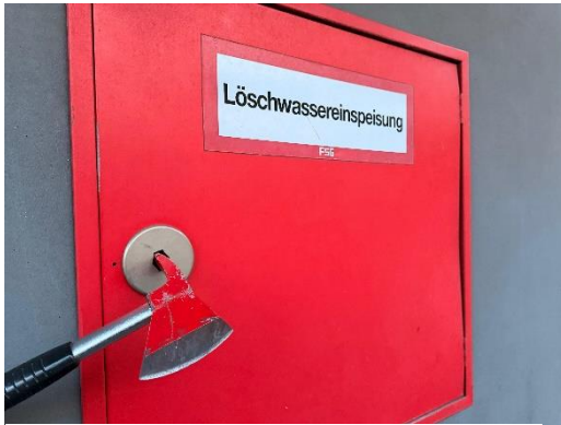
6.5.4-1 Wandhydrant mit Feuerweherschloss – als Schlüssel dient beispielhaft das Feuerwehrbeil
