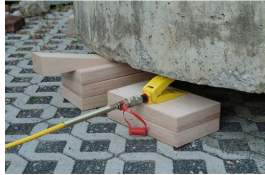
12.3-3 Spreizschnabel beim Heben einer Last
