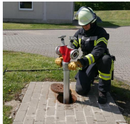
6.5.2-4 Einsetzen des Standrohres
