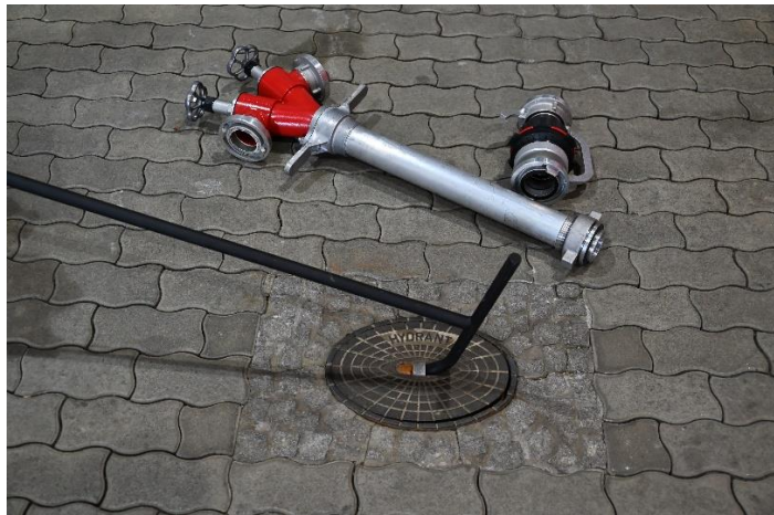
6.5.2-2 Abheben des Straßenkappendeckels
