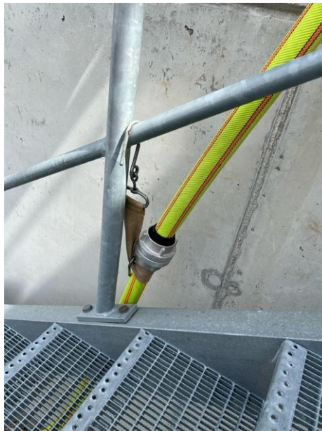
4.4.1-2 Entlastung der Schlauchleitung mittels eines Gurtschlauchhalters
