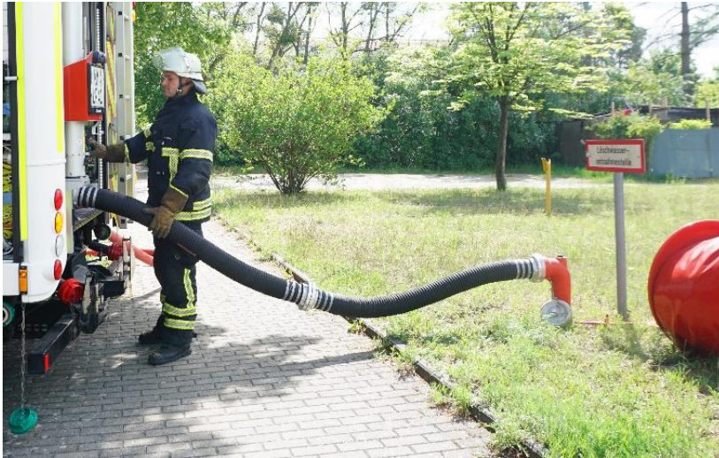
6.4-1 Wasserentnahme mittels Saugschläuchen aus Löschwasser-Sauganschluss
