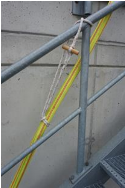
4.4.1-1 Entlastung der Schlauchleitung mittels eines Seilschlauchhalters
