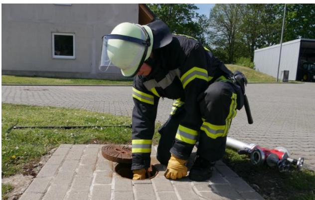
6.5.2-3 Kontrolle des Unterflurhydranten auf Verschmutzung
