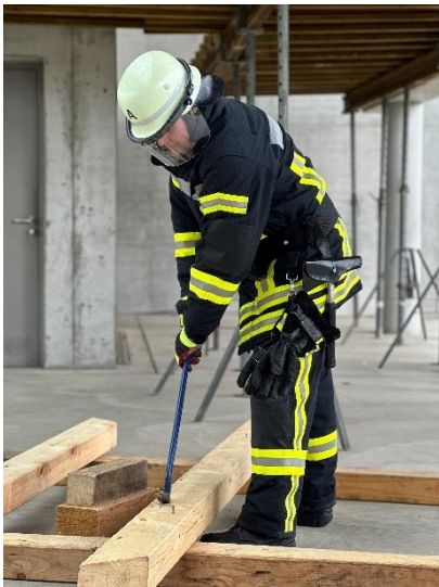
8.3-1 Ziehen von Nägeln mit dem Nageleisen
